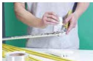
4. Nos encontros de tubos e conexões, o isolamento dos tubos deverá avançar até cobrir a proteção isolante da conexão previamente aplicada.
