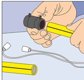
4. Uma vez introduzidos os tubos até a marca, conecte os bornes da luva elétrica ao eletrofusor e siga as instruções de uso do equipamento.
