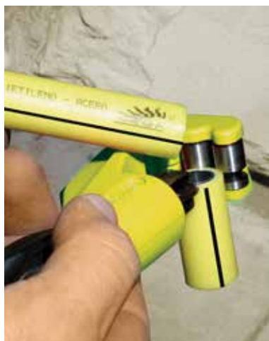
Corte com corta-tubos em obra.
