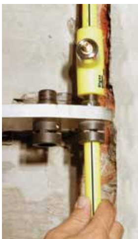
Termofusão do tubo
