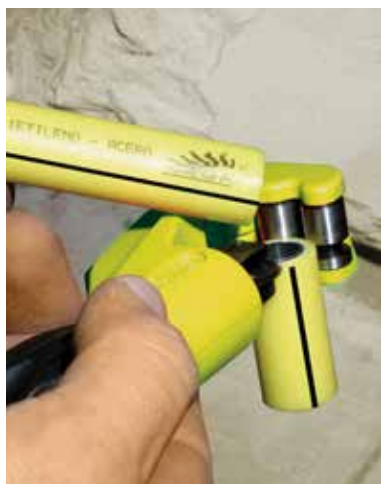
Corte com corta-tubos em obra.
