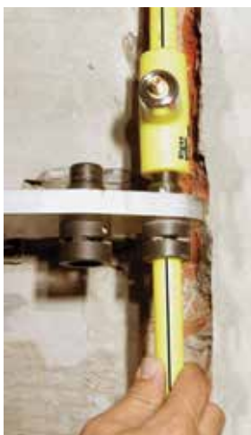
Termofusão do tubo
