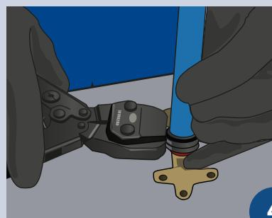
4. Encoste a abraçadeira na extremidade da conexão.
