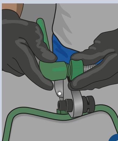
**2.** Imediatamente depois de tirá-los do termofusor, deve-se introduzir rapidamente o tubo na conexão, a introdução do tubo quando os dois anéis que se formam com o movimento do polietileno se juntarem. Deixar repousar cada Termofusão até esfriar totalmente.
