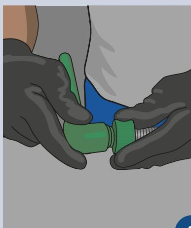
**2.** Imediatamente depois de tirá-los do termofusor, deve-se introduzir rapidamente o tubo na conexão, a introdução do tubo quando os dois anéis que se formam com o movimento do polietileno se juntarem. Deixar repousar cada Termofusão até esfriar totalmente.
